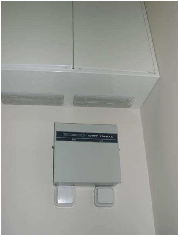
**Вариант установки БП с клавишами управления системой**
