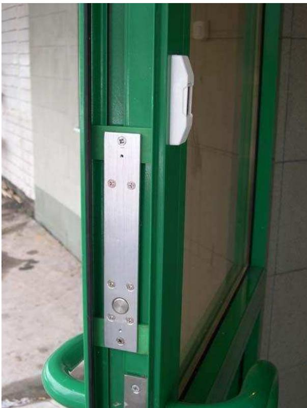
**Вид торца двери с установленным внутренним э/магнитным замком**
